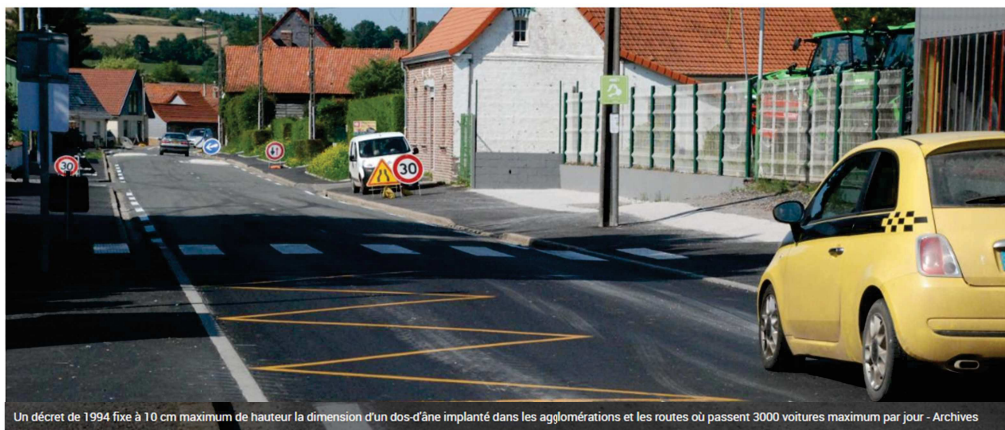
Un décret de 1994 fixe à 10 cm maximum de hauteur la dimension d'un dos-d'âne implanté dans les agglomérations et les routes où passent 3000 voitures maximum par jour - Archives
