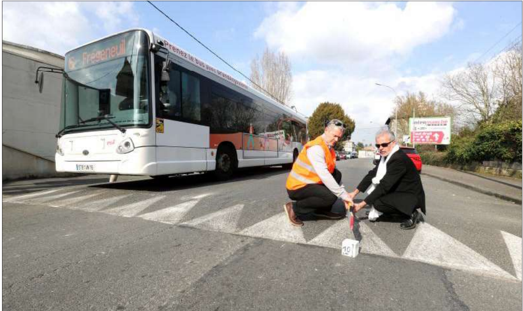
Route de Paris à Gond-Pontouvre. «Sur ce ralentisseur, le rampant est à 15 %. La règle c'est maximum 7 %», assurent trois chauffeurs qui réalisent la mesure. Photo Julie Desbois
