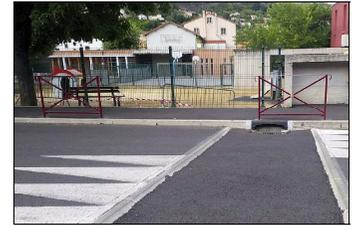
Un modèle de ralentisseur creux, alternative au traditionnel dos-d'âne. Photo Progrès/Rémy DOUTRE
