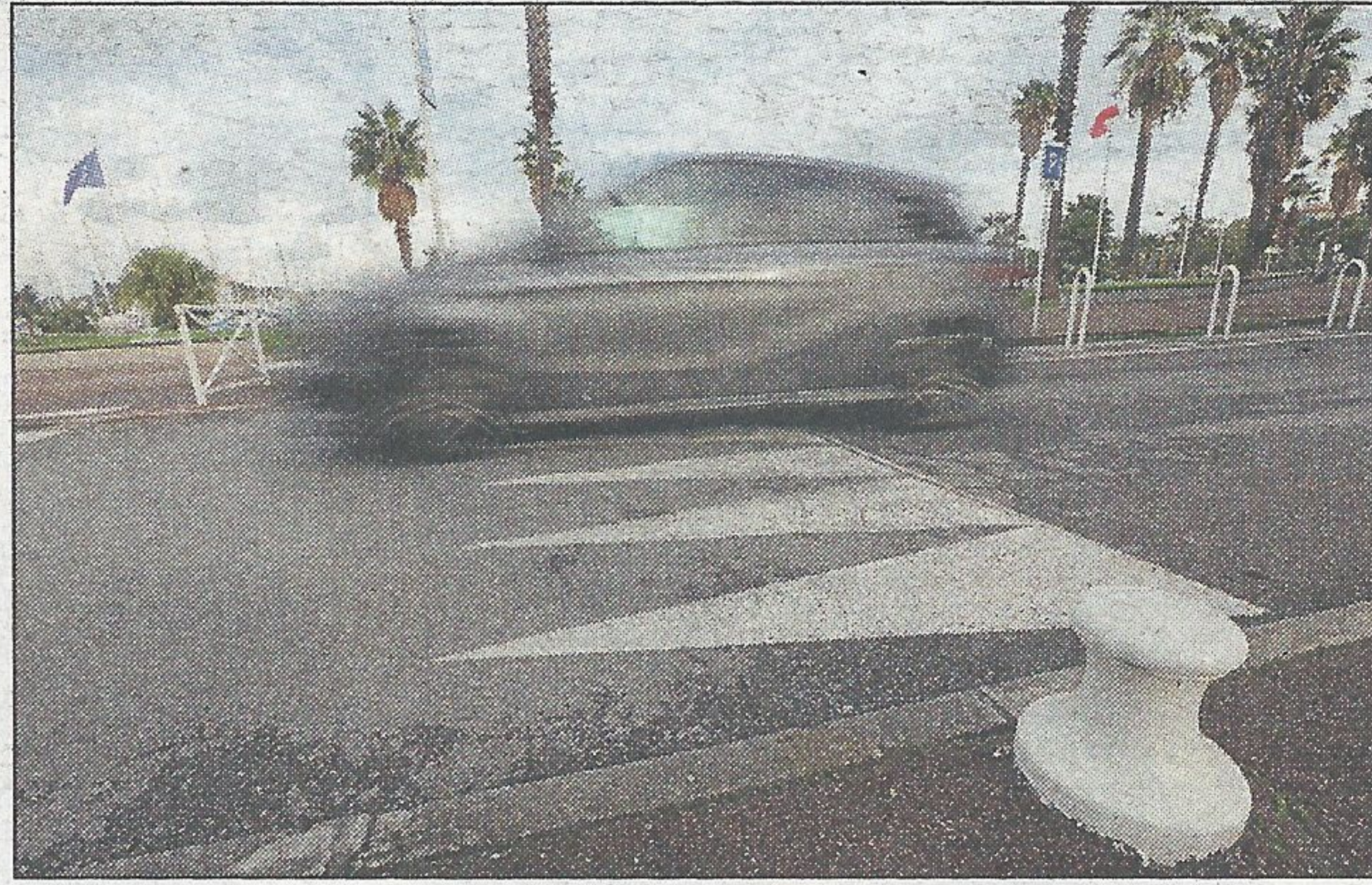
Quelle réglementation appliquer aux ralentisseurs... qui ne sont pas des ralentisseurs ? (Photo doc. E. O.)
