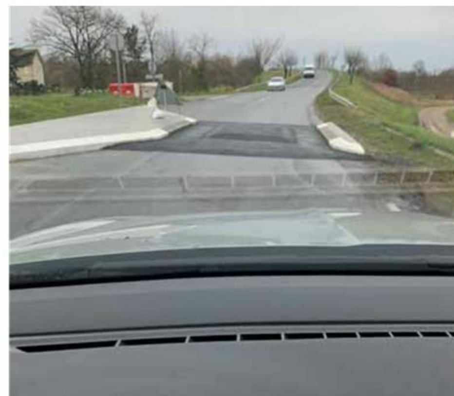
Ce rétrécissement de la chaussée doublé d'un coussin berlinois en béton exaspère les automobilistes. PHOTO C. C.
