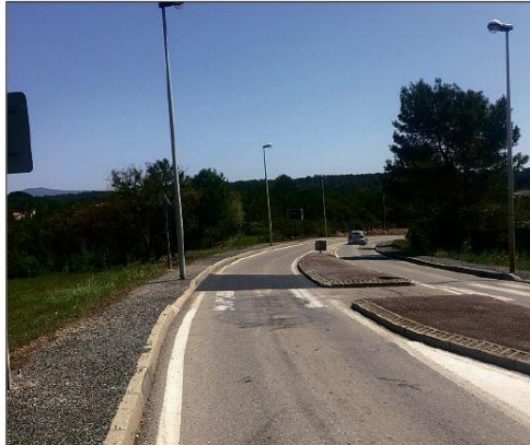
Les travaux de mise en conformité ont eu lieu la semaine dernière.
